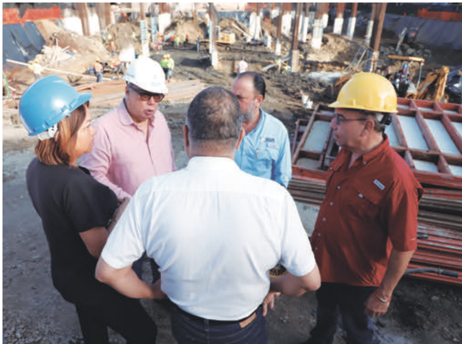
> El Dr. Enrique Lau Cortés inspeccionó el avance de la obra, junto a su equipo de trabajo.
